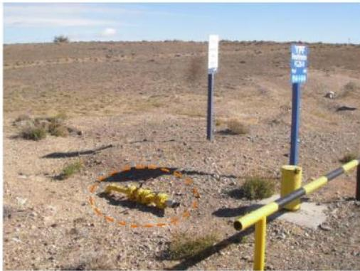
Vista de detalle de la boca de succión del sistema de purga
