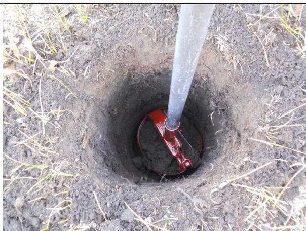
Imagen 7-Realización de pozo freático con pala vizcachera
