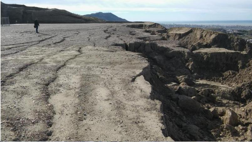
**Cárcava con deslizamiento del borde de talud occidental en locación de pozo petrolero cercano a la rotonda del camino Roque González. (Vista al Norte) en el cerro Arenales.**
