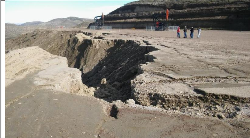
**Cárcava con deslizamiento del borde de talud occidental en locación de pozo petrolero cercano a la rotonda del camino Roque González. (Vista al Sur) en el cerro Arenales.**
